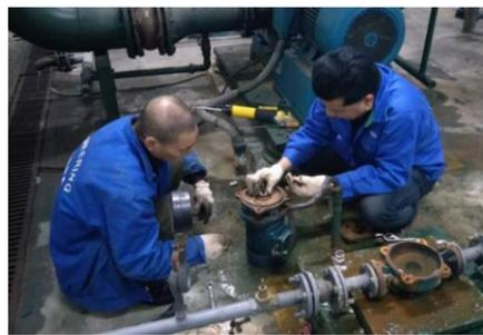
供暖结束后，清洗供暖管道，检修保养供暖循环泵、补水泵，更换水泵盘根、水封、润滑脂，使供暖设备处于良好状态，为下一季供暖提前做好保障准备。
